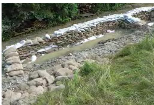
Abb. 34 (links): Fangedämme an großflächigen Austrittsstellen.
