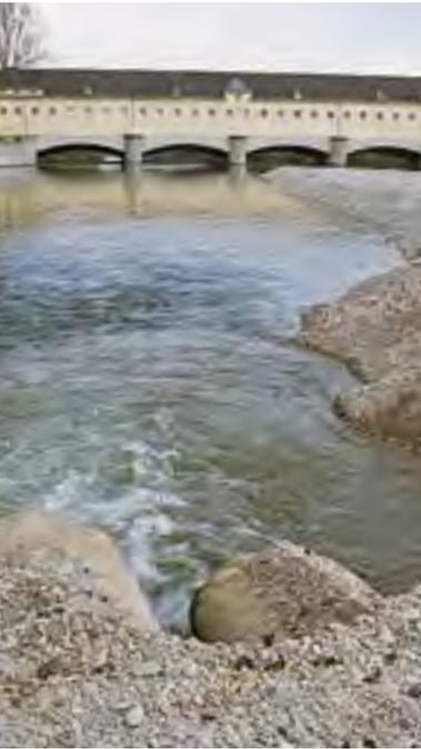
Abb. 88 (links): Im Rahmen des Geschiebemanagements wurden am Oberföhringer Wehr rund 120.000 m<sup>3</sup> Geschiebe aus dem Stauraum in das Unterwasser umgesetzt.
