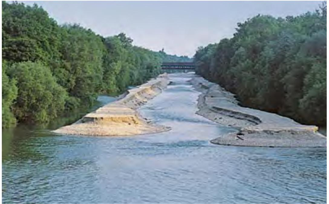
Abb. 89 (rechts): Im Unterwasser aufgeschütteter Kies. Zwischenzeitlich wurde das Kiesmaterial durch Hochwasser flussabwärts verfrachtet, so dass sich dort neue Kiesbänke ausgebildet haben.
