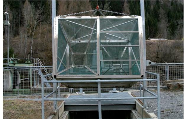
Abb. 24: Regulierbarer Einlauf-/Ausstiegsschlitz mit vorgelagerter Tauchwand (links), rechts: Kontrollreue für Aufstiegs- und Abstiegskontrollen.
