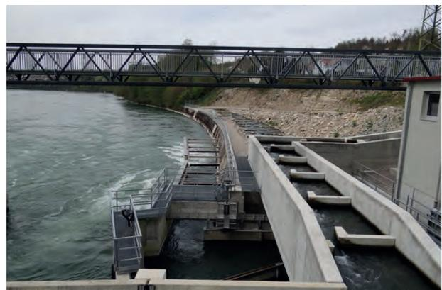
werk Ryburg-Schwörstadt genannt. Dort wurden insgesamt 4 unterwasserseitige Einstiegsstellen errichtet (siehe Abb. 27). Die am Trennpfeiler befindlichen Einstiege werden über einen Schlitzpass quer über den Turbinenauslass des Kraftwerks zum rechten Ufer geführt und dort mit den anderen Ausstiegssträngen (Schlitzpass und naturnaher Umgebungsbach) zusammengeführt.
