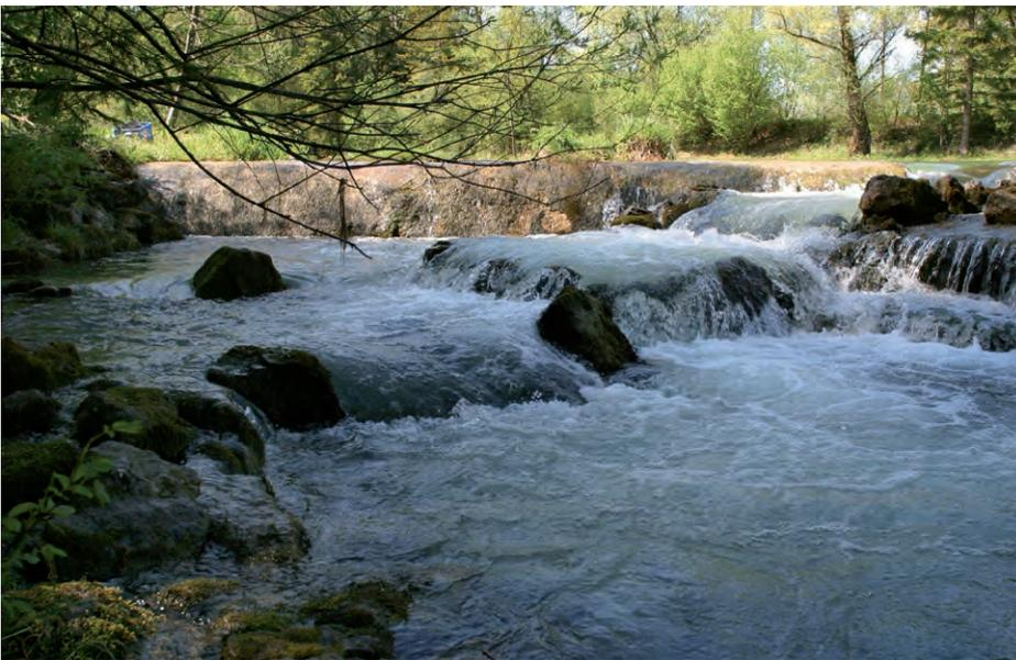
Abb. 15: Unpassierbarer Tümpelpass: Becken zu klein, Höhengsprünge zu groß, teilweise abgelöster Strahl, zu hohe Geschwindigkeiten, hydraulisch überlastet (Baujahr 1993).
