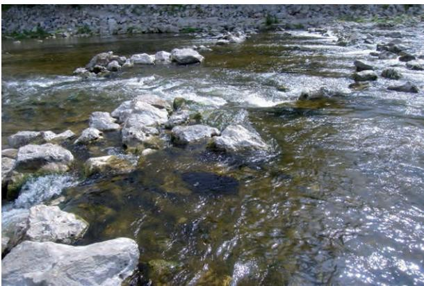
Detail Querriegel mit Übergang der Niedrigwasserrinne:
