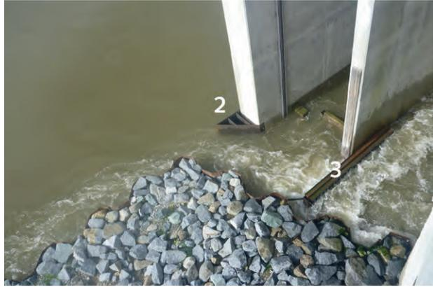
Detail Einstieg nach Umbau, Zusatzdotationsmenge ca. 0,5 m<sup>3</sup>/s
