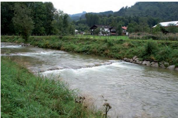
Detail Rampenförmig umgebaute Sohlschwelle:
