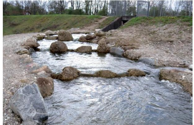
Abb. 42a) 42b): Tümpelpass am Alz-Wehr Tacherting mit großzügiger geometrischer Dimensionierung und sehr moderaten hydraulischen Bedingungen, größenbestimmende Zielart: Huchen (Inbetriebnahme 2014).
