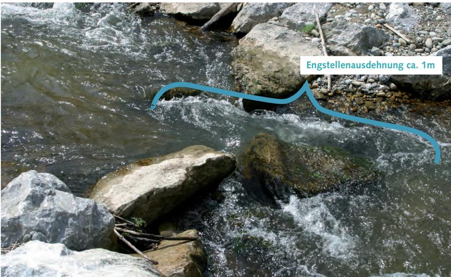
Abb. 21: Eingeschränkte Passierbarkeit durch zu langen und zu flachen Schwellenübergang.
