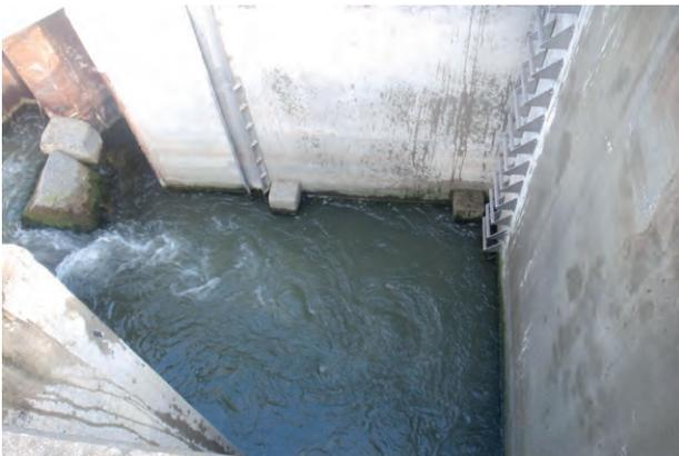
Ausstiegsbereich im Oberwasser nach Einbau des Schwimmbalkens/Treibgutabweisers
