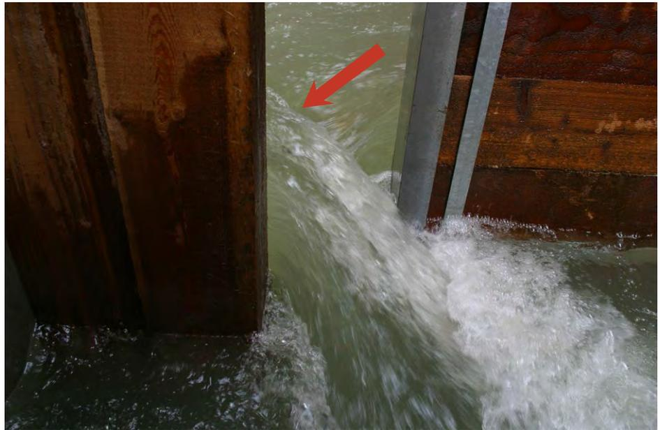
Abb. 18: Schlitzpass als eingeschränkt passierbarer Bereich: Hydraulischer Kurzschluss und Strömungsbeschleunigung durch falschen Strahlaustrittswinkel (rote Pfeile) im Schlitz (Wandkrümmung nicht ausreichend beachtet). Die weißen Pfeile zeigen die erwünschte „korrekte“ Strömungsrichtung an.
