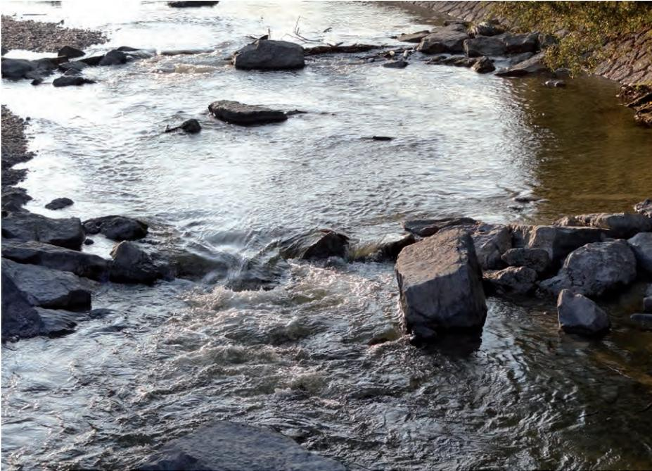
Abb. 40: Schwellen (Tümpelpass mit gut passierbaren Hauptübergängen, gute Energieumwandlung.)
