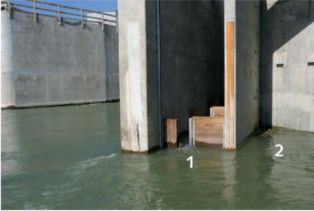
2 ) Übersicht Einstieg nach Umbau mit Vorschüttung/Spundwand (1), Leitelement (2) und Rechen zur Vergleichmäßigung der Zusatzdotationsmenge (3), Zusatzdotationsmenge ca. 1,0 m<sup>3</sup>/s
