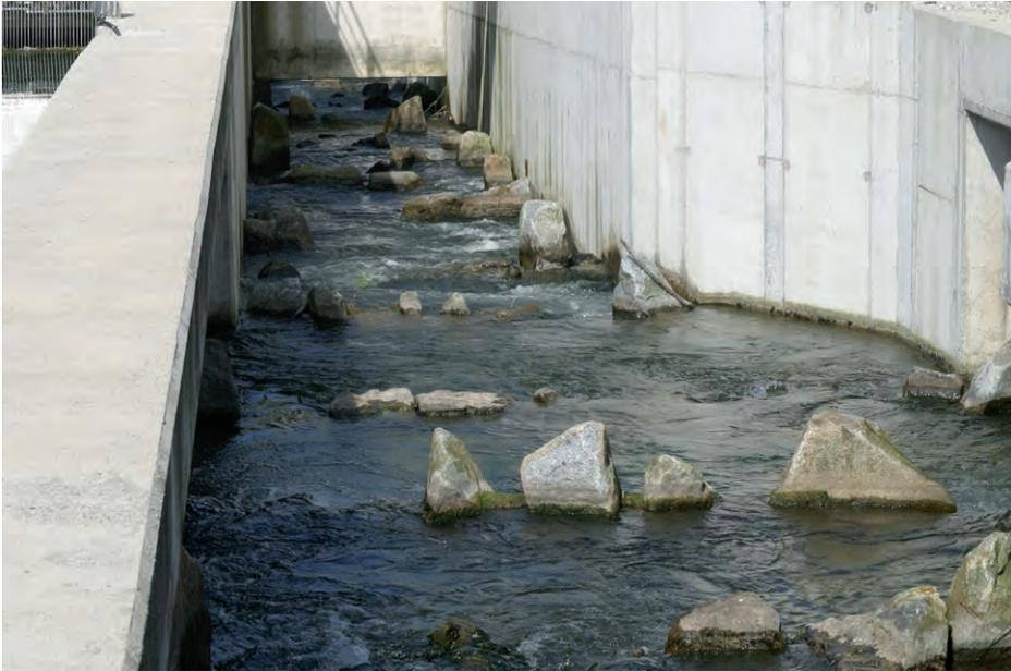
Abb. 46: Raugrinne-Beckenpass nach erstem Probebetrieb (unten) und im Normalbetrieb (oben).
