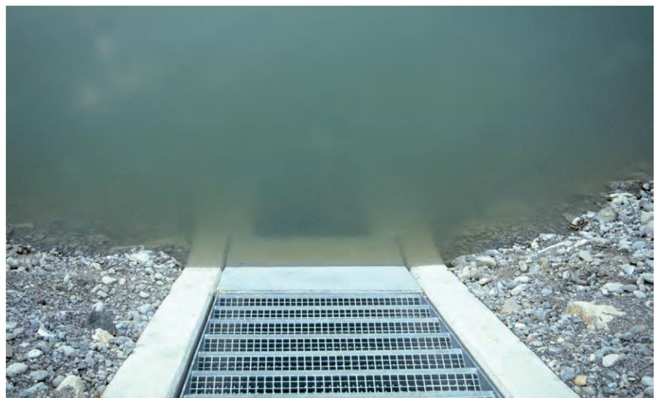
Abb. 26: Einlauf-/Ausstiegsbauwerk mit Tauchwand.
