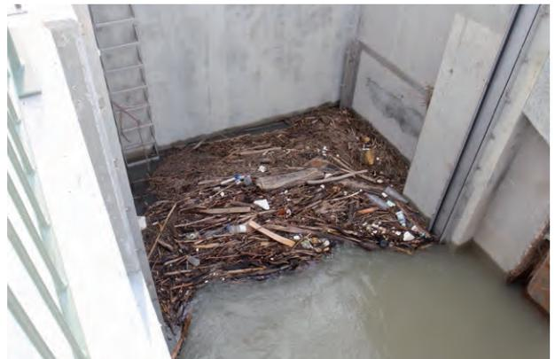
Abb. 25: Pfahlrechen (links) mit unzureichender Schutzwirkung, rechts: Folgewirkung.
