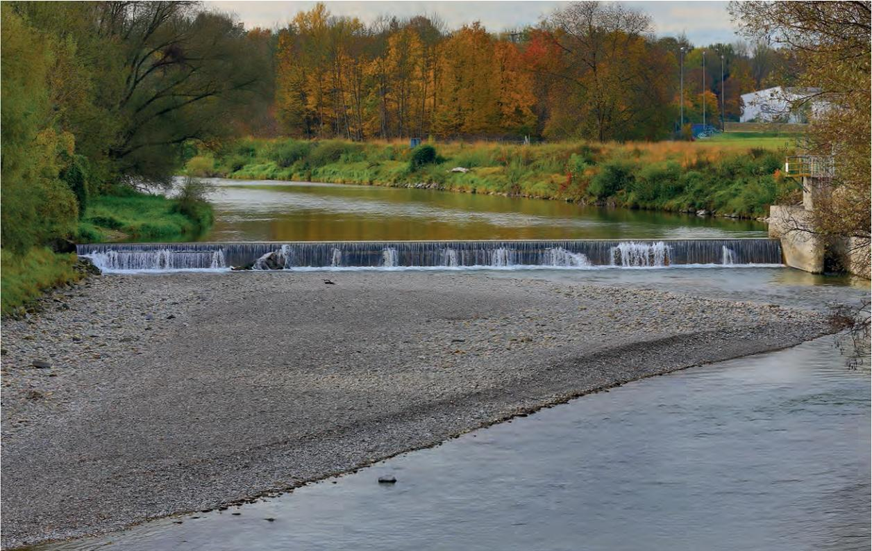
Übersicht Sohlgleite nach Umbau von unterstrom: linksseitig (orografisch) beckenförmige FAA, rechtsseitig Blocksteingleite mit Niedrigwasserrinne
