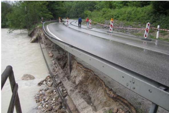
Abb. 5-4: Uferschaden an der B 305
