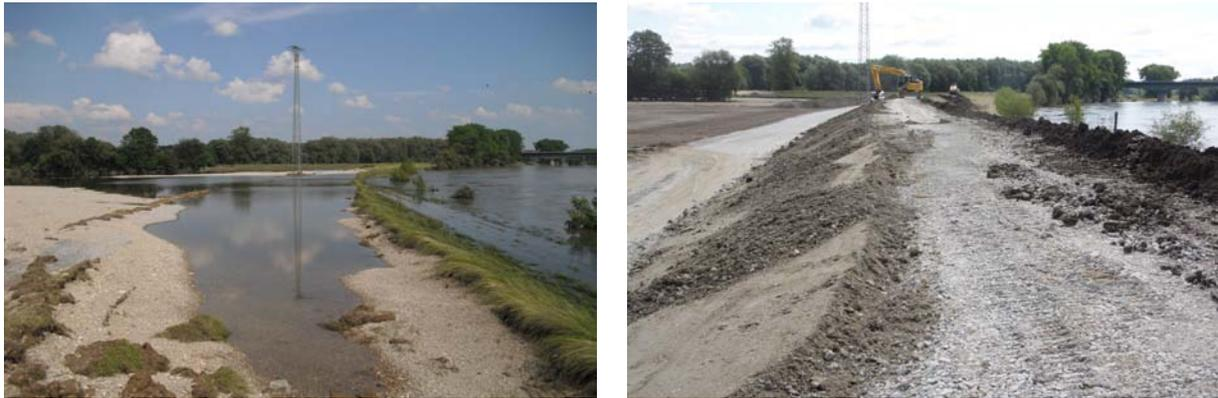
Abb. 4-5: Deichbruch Auterwörth, Bruchstelle und Schadensbeseitigung nach dem Hochwasser 2013
