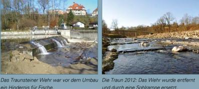
ein Hindernis für Fische. Das Wehr an der Traun diente bis 2010 als Ausleitungsbauwerk für den Triebwerkskanal der Traunsteiner Wasserkraftwerke und stellte für Fische
