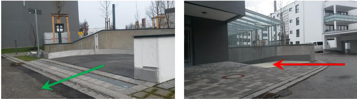
Abb. 6-4: Mit einfachen Mitteln lassen sich im Rahmen der Bauvorsorge Risiken wirkungsvoll reduzieren. Beispielsweise kann bei Tiefgarageneinfahrten mit einer Schwelle weitgehend verhindert werden, dass Oberflächenwasser von der Straße aus eindringen kann (links). Im anderen Fall besteht die Gefahr, dass schon bei geringen Wasserständen auf der Straße Wasser in die Tiefgarage läuft (rechts).
