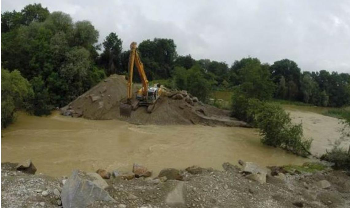
Abb. 4-12: Polderentleerung durch Dammbresche zum Inn
