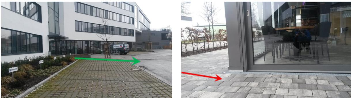
Abb. 6-5: Das umliegende Gelände sollte so gestaltet werden, dass Niederschlagswasser vom Gebäude wegfließen kann (links). Ein Gebäude, dessen Erdgeschoss unter dem Straßenniveau liegt, ist bei Starkregen besonders gefährdet.
