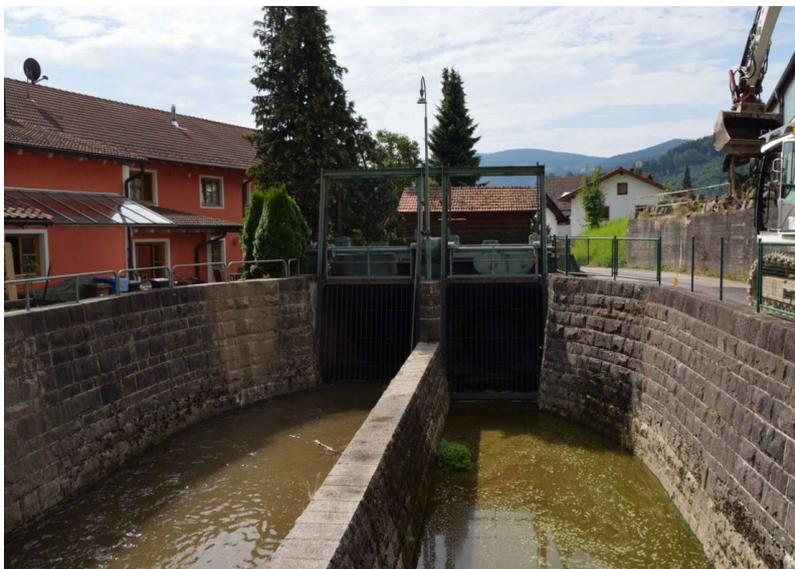
Abb. 3-4: Einlaufbereich in die Verrohrung des Eckerbachs in Oberzell. Bis zur Mündung in die Donau verläuft der Eckerbach auf einer Länge von circa 400 Metern in einer Verrohrung durch den Ortsbereich.
