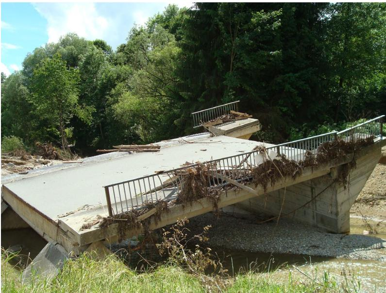
Abb. 3-22: Völlig zerstörtes Brückenbauwerk am Tanner Bach, Landkreis Rottal-Inn
