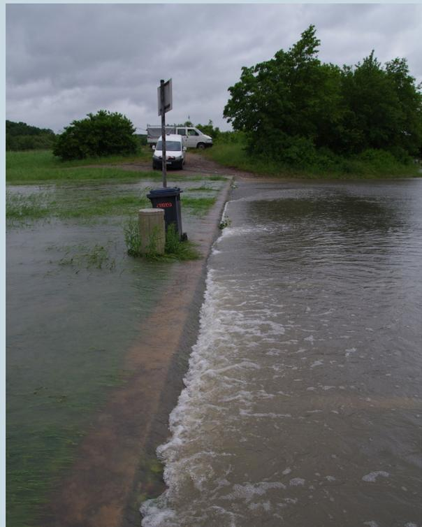
Abb. 4-7: Überströmte Hochwasserentlastungsanlage
