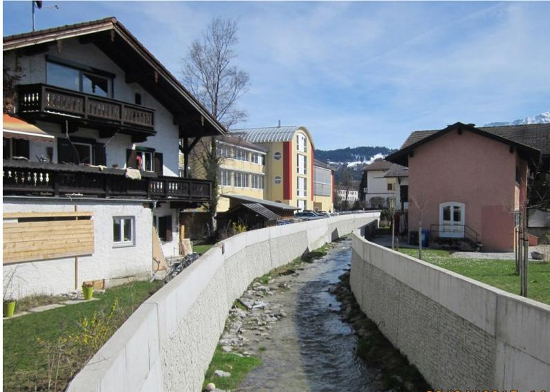
Abb. 3-3: Gerinne der Kanker in Garmisch-Partenkirchen. Die bis dicht an den Gewässerlauf heranreichende Bebauung, lässt nur noch ein schmales Betonschussgerinne zu. Im nicht auszuschließenden Überlastfall sind Schäden vorprogrammiert.
