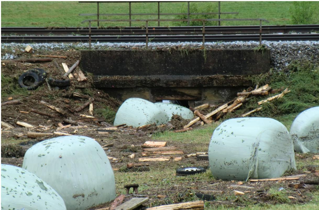
Abb. 3-14: Mit Silageballen und Brennholz verstopfter Durchlass unter der Bahnlinie zwischen Ansbach und Würzburg bei Oberdachstetten (Landkreis Ansbach).
