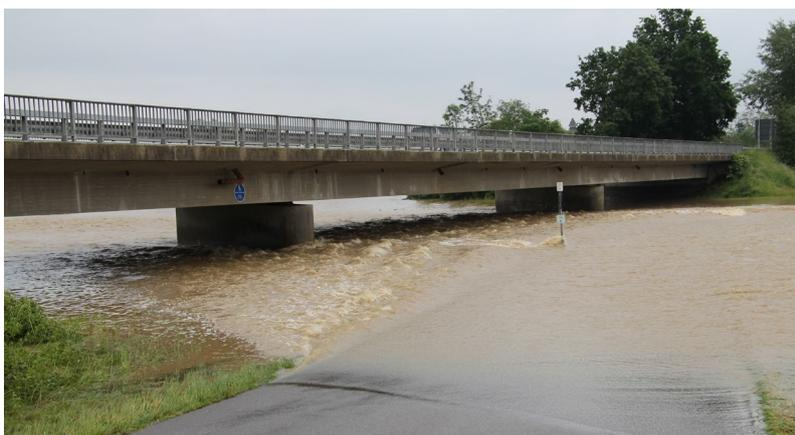
Abb. 5-3: Flutmulde unter der Brücke der B388 – ohne Wasser (oben) und gefüllt beim Ereignis 2016 (unten), Markt Ruhstorf, Landkreis Passau
