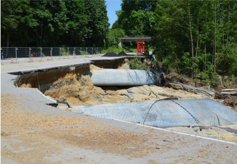
Abb. 3-21: Freigelegte Wellstahldurchlässe an der Anschlussstelle B 12/St 2112
