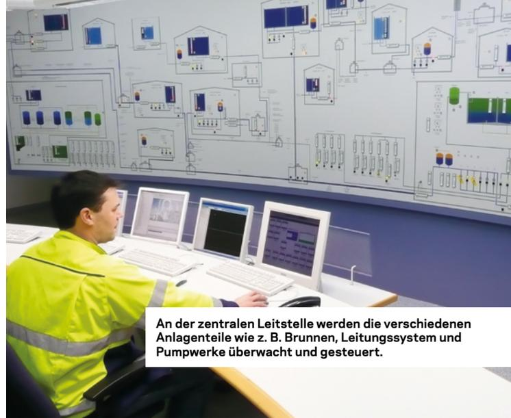
An der zentralen Leitstelle werden die verschiedenen Anlagenteile wie z. B. Brunnen, Leitungssystem und Pumpwerke überwacht und gesteuert.
