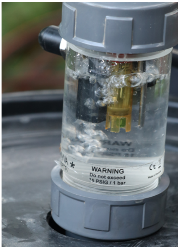
Abb. 13: Fotobeispiel „Technische Unzulänglichkeiten“ – Lufteintrag in Durchlaufzelle
