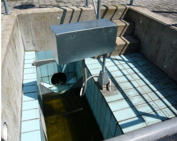
Abb. 3: Dreieckmesswehr in Betrieb
