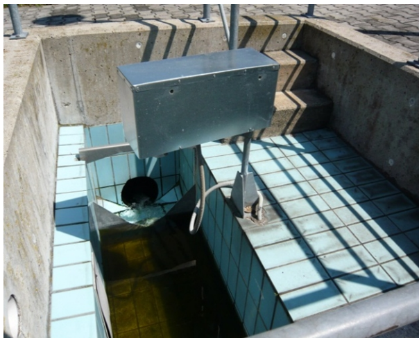
Abb. 3: Dreiecksmesswehr in Betrieb
