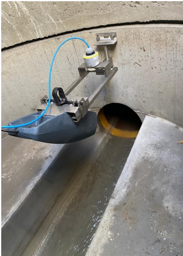
Abb. 13: Beispiel einer Radarmessung
