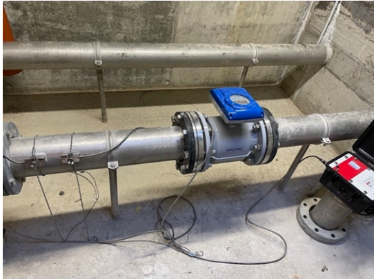
Abb. 9: Beispiel eines Aufschnallgerätes (Clamp-On)
