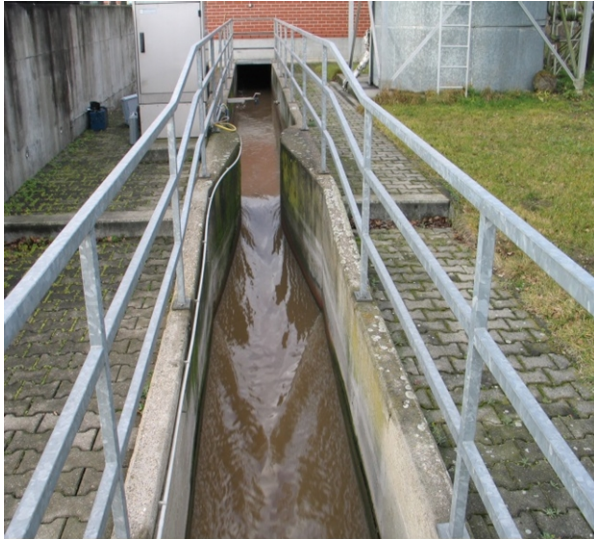
Abb. 6: Beispiel eines Venturi-Gerinnes
