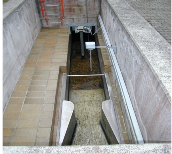
Abb. 7: Beispiel eines weiteren Venturi-Gerinnes
