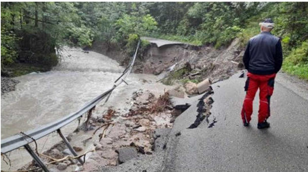
Abb. 64: Durch Uferanbruch zerstörte Straße im Mühlthal (Steinbach, Nussdorf am Inn) (Foto: WWA Rosenheim)
