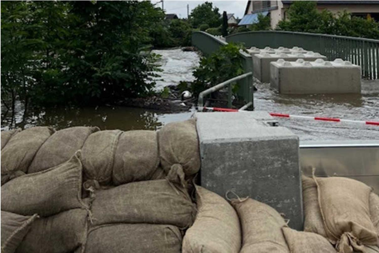
Abb. 101: Im Bereich des Paarstegs in Manching kam es zur Überströmung des Stegs. Dies führte zu einem Rückstau und einer teilweisen Verkläusung. Die Einsatzkräfte reagierten schnell, erhöhten die Sandsackbarrieren und beschwerten den Steg zusätzlich mit Betonelementen (Foto: WWA Ingolstadt).
