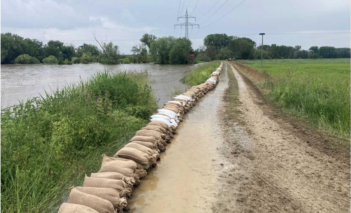
Abb. 61: Mit Sandsäcken erhöhter Deich südlich von Ilmendorf (Foto: WWA Ingolstadt)
