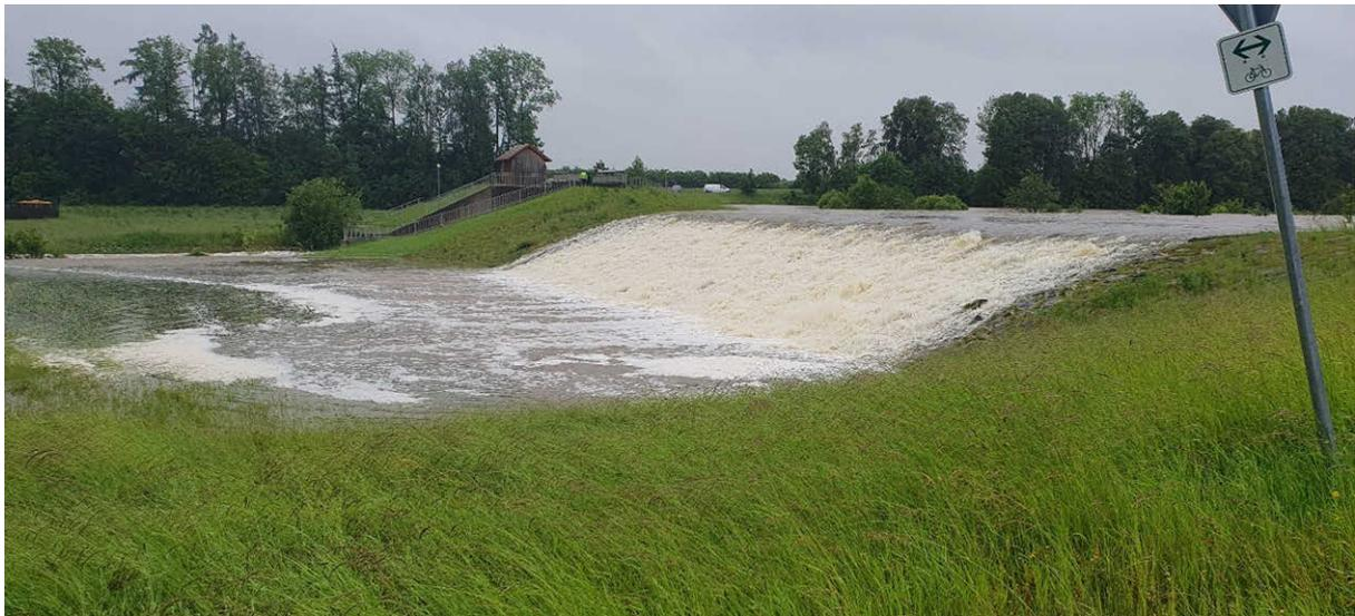
Abb. 39: Beaufschlagte Hochwasserentlastungsanlage an einem HRB im Landkreis Unterallgäu (Foto: WWA Kempten)
