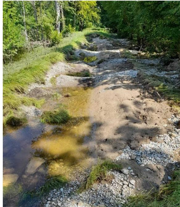
Abb. 44: erodierte Deichstreckte bei Steinheim (Foto: WWA Donauwörth)
