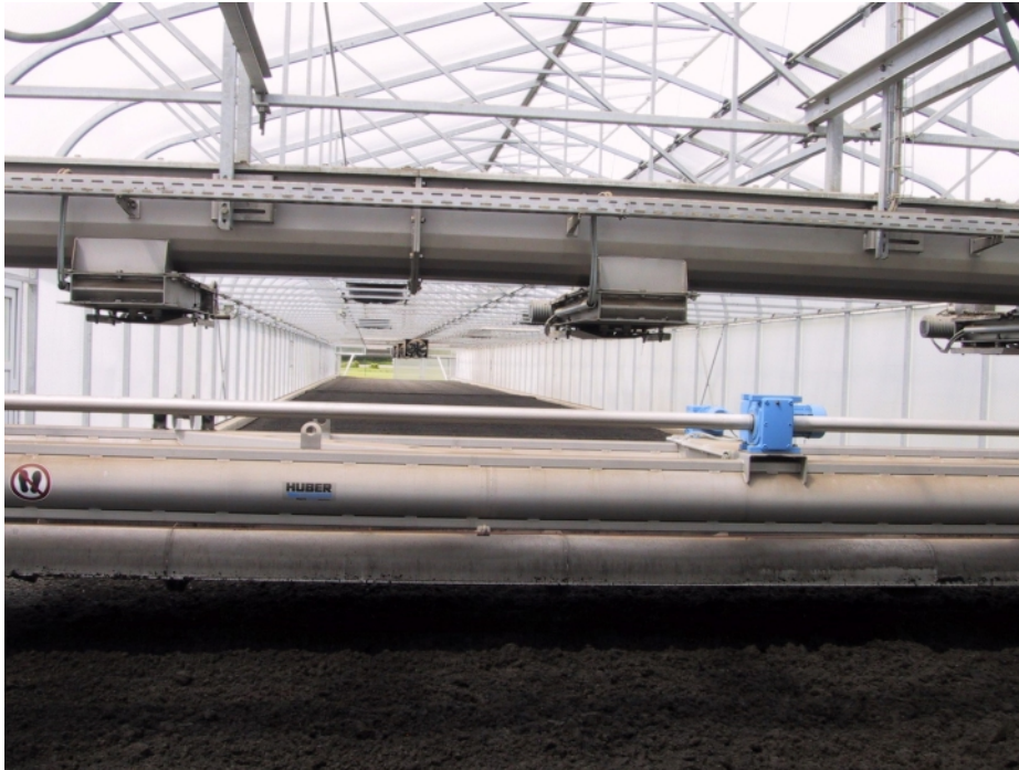
Abb. 12: Solare Klärschlamm- trocknung auf der Klär- anlage des Abwas- serzweckverbands Penzing-Weil
