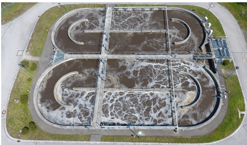
Abb. 15: Belebungsbecken der Kläranlage Weilheim in Oberbayern
