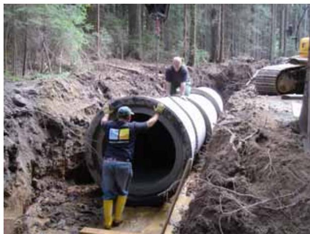
Abbildung 26: Für die Teilerneuerung des Fischottergeheges war eine temporäre "Bypass-Rinne" erforderlich (Foto: W. Kirchner).
