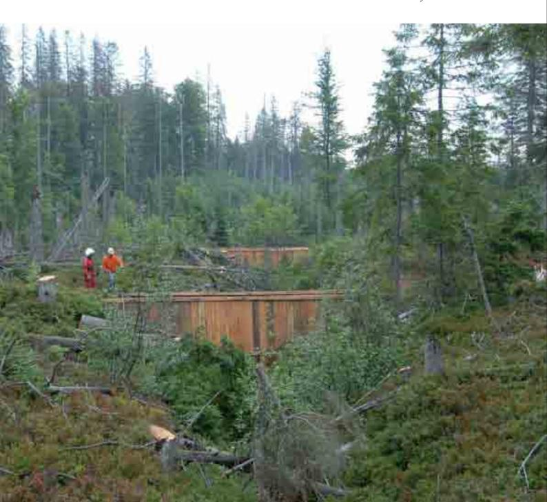
baut man eine 3,5 Meter hohe Spundwand? Können die benötigten 4,5 Meter langen Bohlen noch händisch einrammt werden oder bräuchte man dazu einen Bagger, der wahrscheinlich im Moor einsinken würde? Wie bringt man größere Mengen an Bohlen und Hackschnitzeln überhaupt ins Zentrum des Moores ohne größere Schäden an der Torfdecke anzurichten? Fragen, die immer wieder diskutiert worden sind, ohne dass man zu wirklich befriedigenden Antworten gelangt war.
