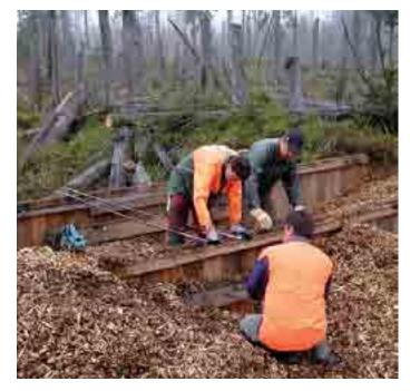
Stabilisierung einer mit Hackschnitzeln gefüllten, 3 Meter hohen Doppelwand mit Eisenstangen, um ein Ausbauchen der Wände zu verhindern Foto: Karl-Heinz Englmaier
