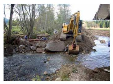
Wiederherstellung früherer Mäanderschleifen am zur Trift begradigten Kolbersbach - mit dem Bagger in wenigen Stunden erledigt (Foto: Ingo Brauer)
