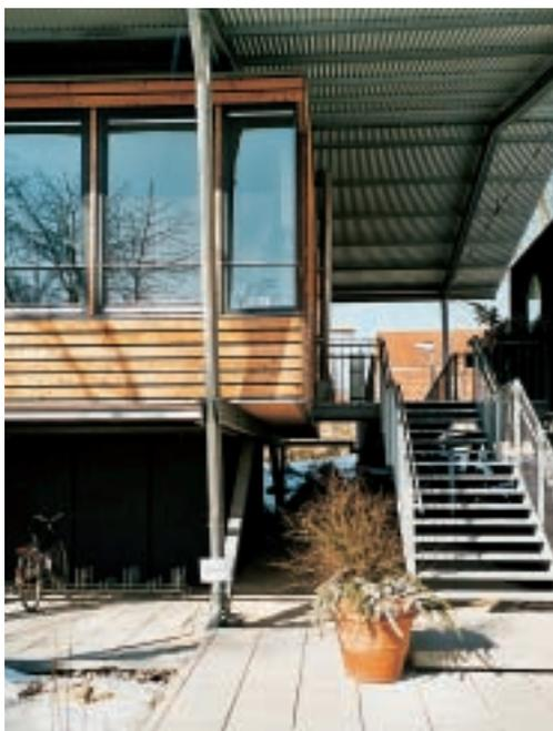
*Bild links: Sonderlösung für bestehende Bebauung in Kallmünz: Der Ersatzbau des Ärztehauses wurde auf Stahlständern errichtet.*
