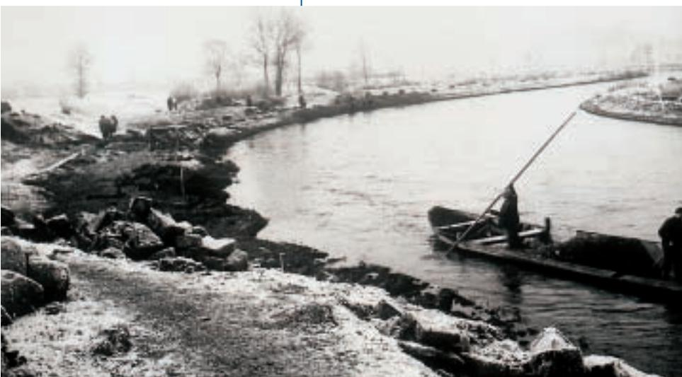
*Bild:* Für die Flößerei begradigter und eingengter Main (nach 1880).
