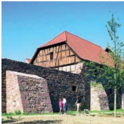
*Bild links:* Die Stadtmauer von Würth schützt heute vor Hochwasser – moderne Schutztechnik wurde in historisches Mauerwerk integriert.
