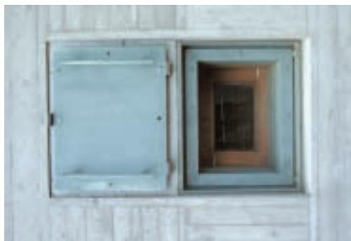
*Bild links:* Bei Hochwasser wird dieses Fenster mit einer Edelstahl-Klappe wasserdicht verschlossen.
