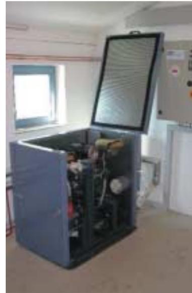
Energie-Plus-Haus: Ein großer Teil des Wärmebedarfes dieses Hauses wird durch die Solararchitektur abgedeckt, der Rest durch ein Pflanzenöl-BHKW. Dieses liefert zusammen in den Photovoltaik-Modulen auf dem Dach mehr Strom, als für den Eigenbedarf benötigt wird. Außerdem wird Wärme zur Warmwasserbereitung – zusammen mit den Sonnenkollektoren auf dem Nebengebäude – erzeugt.
