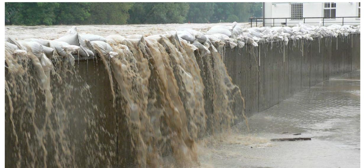
Eine Hochwasserschutzmauer mit Sandsäcken in Kempten wird 2005 beim extremen Hochwasser der Iller überspült
