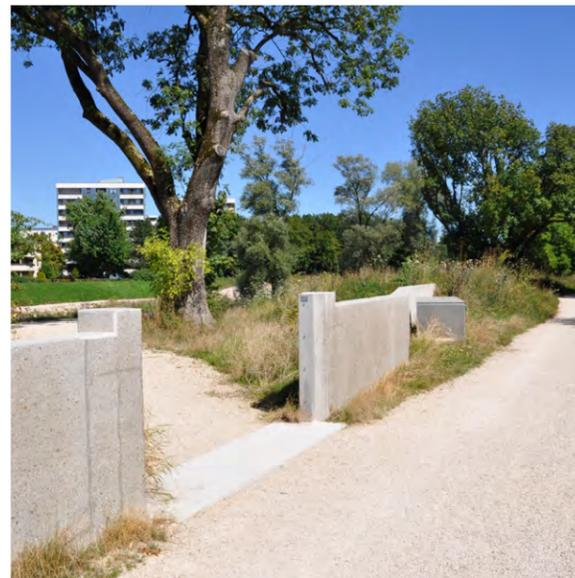
Eine Hochwasserschutzmauer an der Wertach (der Durchgang kann mit Dammbalken verschlossen werden)
