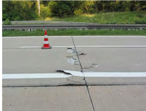
Die Hitzewelle im Juli 2013 führte an einzelnen Stellen im Straßennetz zu Schäden am Straßenbelag, vorrangig an Betonfahrbahnen mit einem Lebensalter von bereits über 30 Jahren
