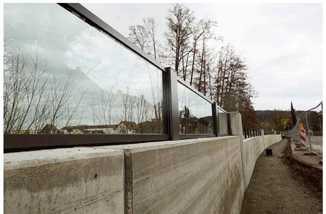
*Fertiggestellte Hochwasserschutzwand mit Glasaufsatz, Nähe Rampe (Jahr 2014)*
