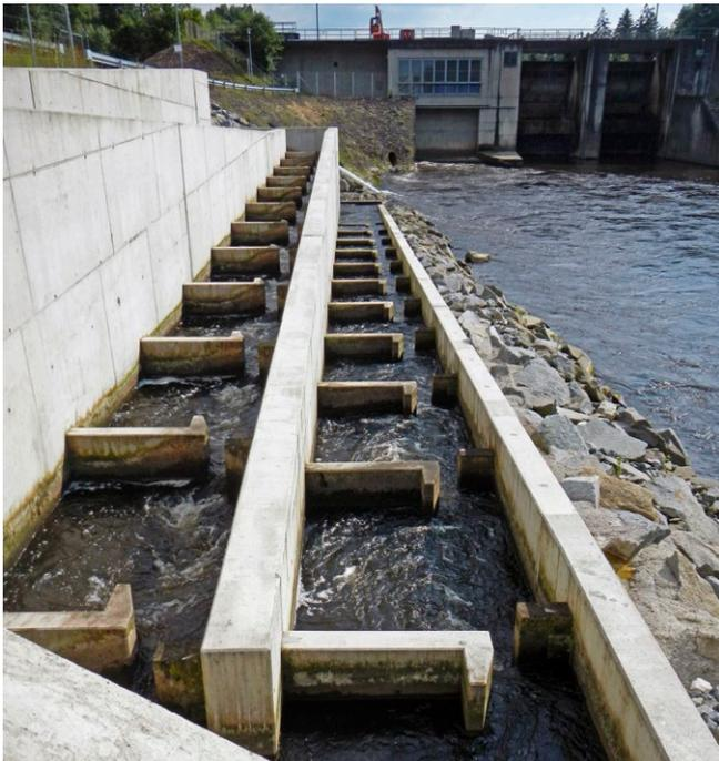
Technische Fischaufstiegsanlage (Schlitzpass)
