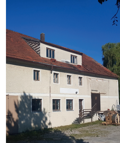
Bild links und Titelseite: Sanierung und Umbau des Pfarrstadels in Lohkirchen vorher und nachher
